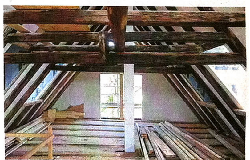
Mächtiges Gebälk im Dachstuhl: Auch alte Häuser müssen modernen Bauvorschriften genügen. Das historische Ambiente wird trotzdem erhalten.
